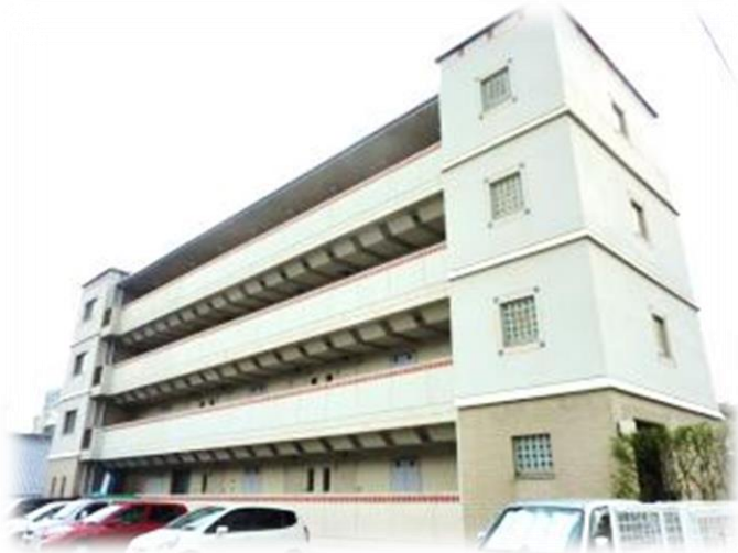
宿舎の外観の一例
